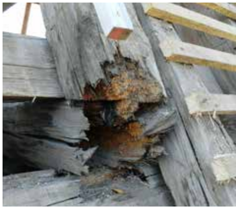
Schadhafte Stellen am Dachstuhl, hier an einem Sparren und Kehlbalken, wurden ausgebessert, statisch ertüchtigt und erneuert
