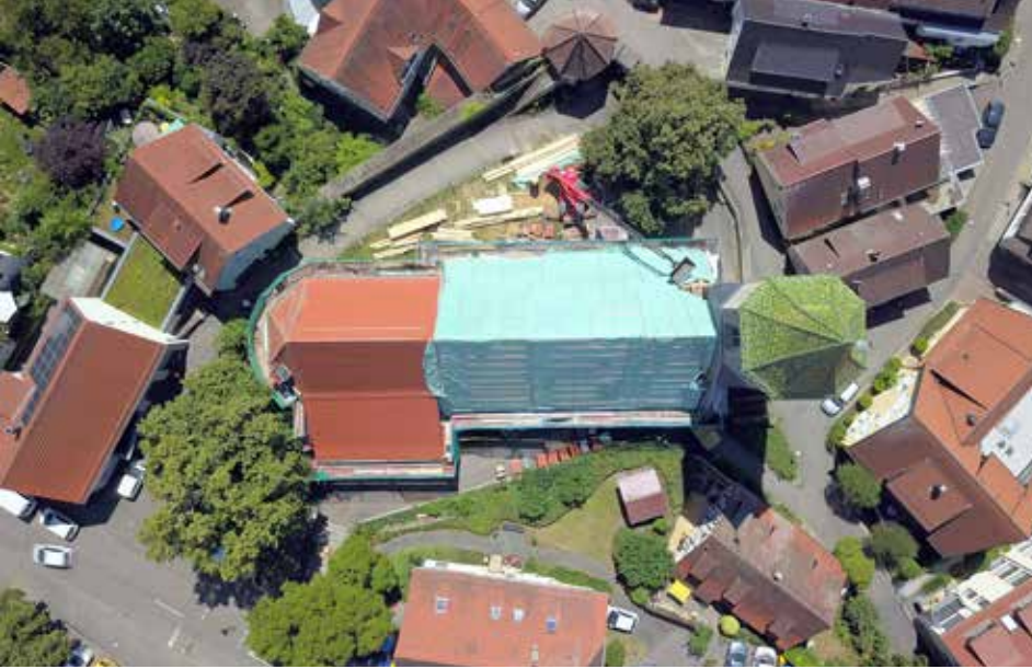
Das Material für die Sanierung wurde per Teleskopklader in das Dach transportiert
