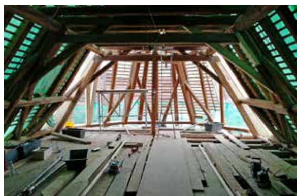
Über den Dachstuhl des Chors, der gegenüber dem Westturm der Kirche liegt, wurde ein temporärer Zugang zum Dach geschaffen Fotos: Holzbau Dippon
